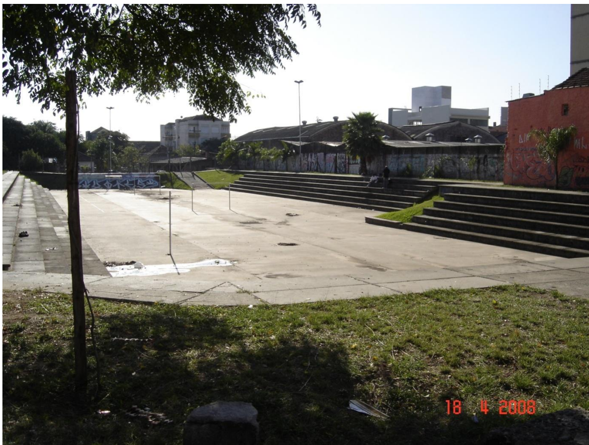
FIGURA 35 Bacia de Detenção aberta na Avenida Polônia – Porto Alegre - RS
